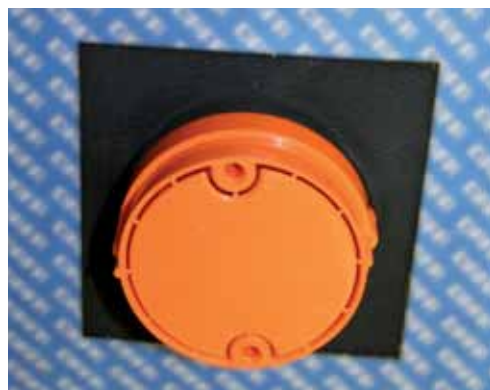
Eksempel på vindtæt installation med universalkrave.
